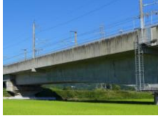
橋梁の定期点検
