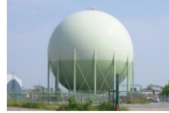
屋外貯蔵タンクの点検
