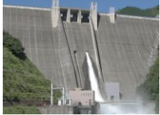
ダム堤体の点検
