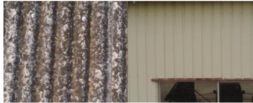
屋根/外壁などの家屋調査
