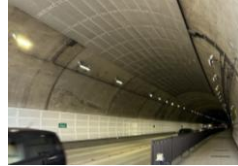
トンネル内部の点検
