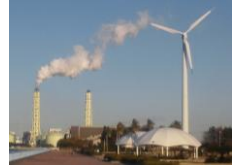
風力発電のブレード点検
